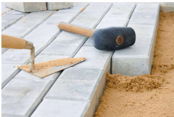
Figura 2 – Vazios dos blocos preenchidos com areia.
