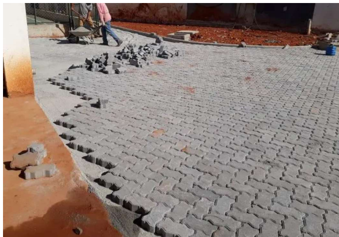
Figura 1 – Assentamento de paver Tipo I (16 faces).
