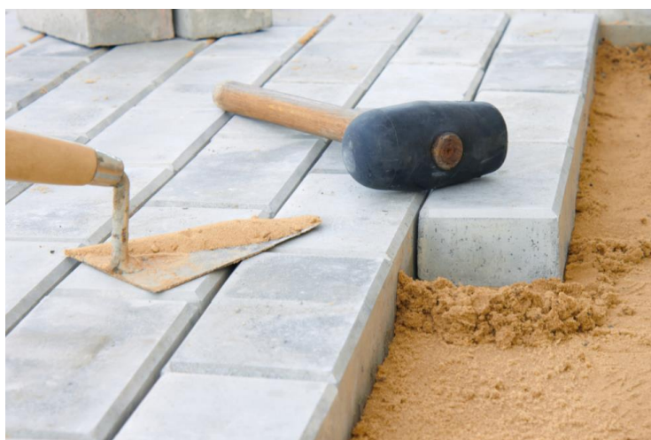
Figura 2 – Vazios dos blocos preenchidos com areia.
