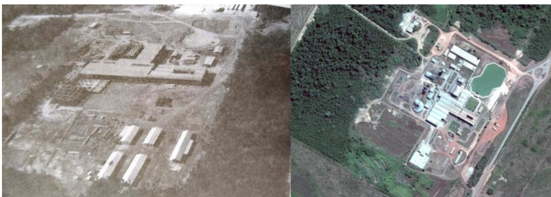
Figura 4: Construção do Atlas Frigorífico e imagem de satélite do atual frigorífico JBS. Fontes: Construção do Atlas Frigorífico. VITA, Henrique (2004, p.54) Campo Alegre, Santana e eu. Atual frigorífico JBS. OECO. Disponível em: https://bit.ly/2WJbtGm . Acesso em: 15 mai. 2019
