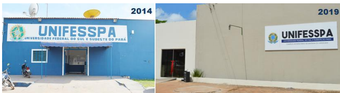
Figura 5: Instalações provisórias da Unifesspa (2014-2019)
