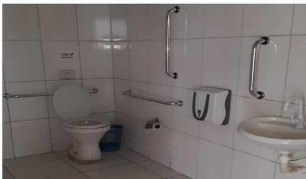
Figura 1. Banheiro Adaptado- NBR 9050
